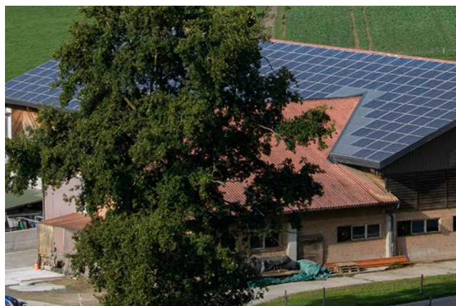
Panneaux solaires, ferme à Noréaz
