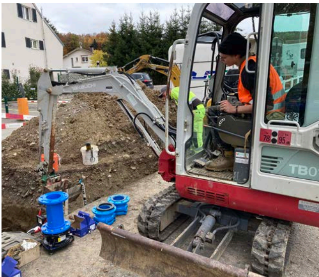
Route de Fribourg, pose de la conduite de bouclage
